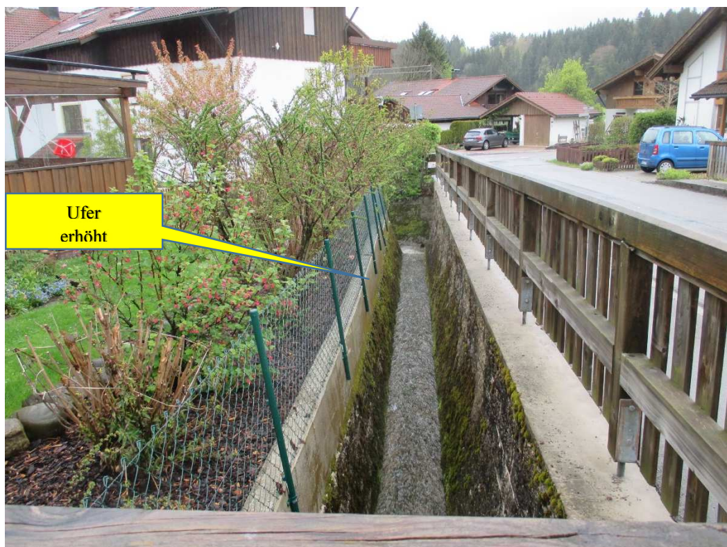
Abbildung: seitlicher Zufluss, nach einem Durchlass oberhalb der Einmündung in den Dorfbach
