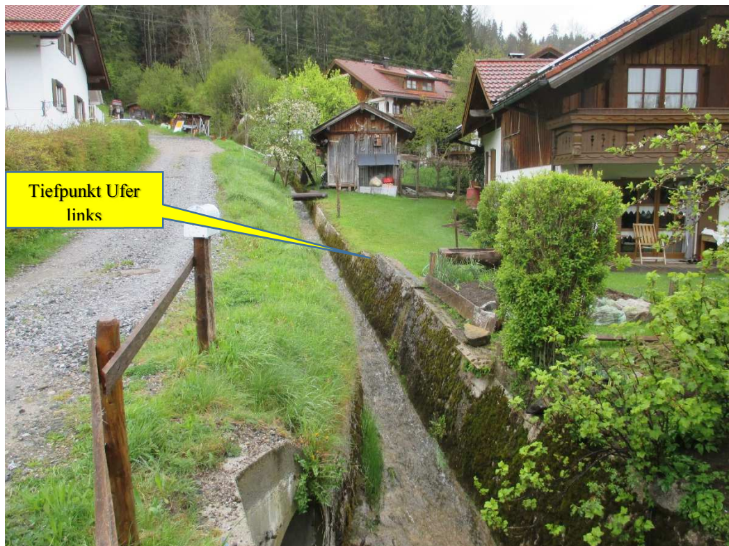
Abbildung: seitlicher Zufluss, von links in den Dorfbach (oberer Beriech, mit unterschiedlichen Uferhöhen orografisch links)
