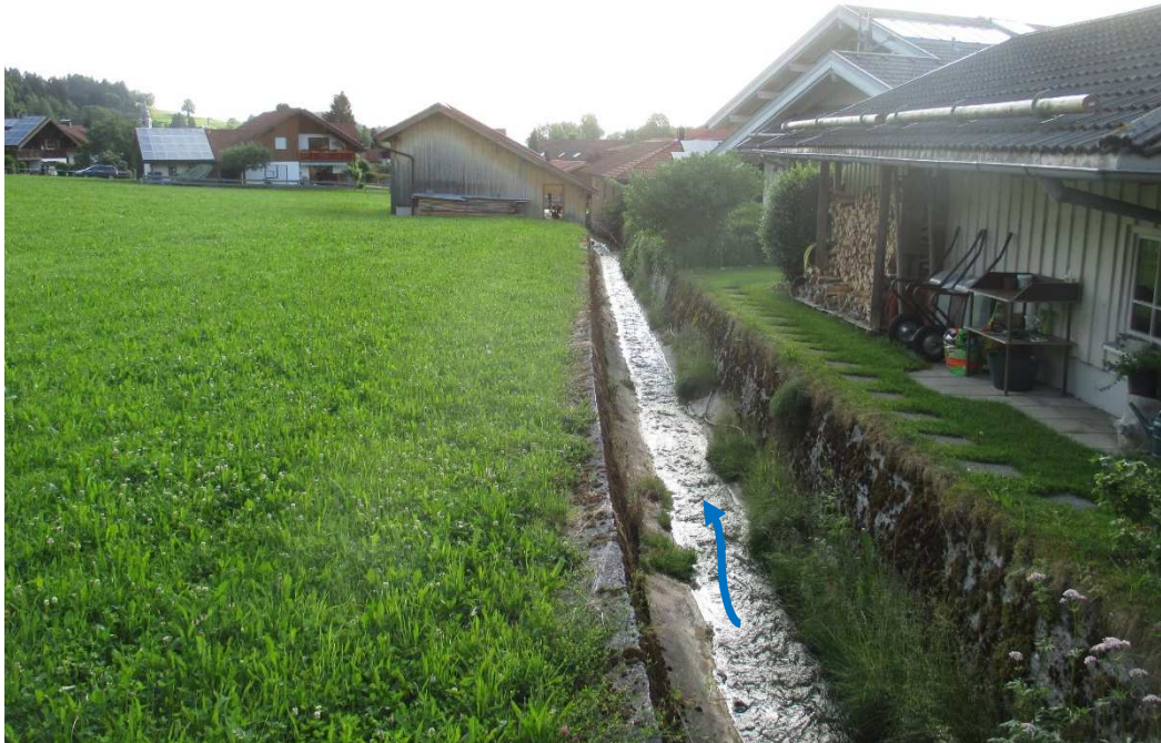
Abbildung: westlicher Teil der Wohnbaufläche orografisch links des „hart ausgebauten“ Dorfbachs
