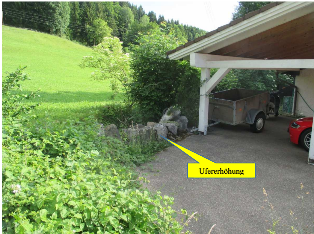
Abbildung: Zuflussbereich des Dorfbachs im Übergangsbereich zum hart ausgebauten Gewässerabschnitts mit zusätzlicher Ufererhöhung orografisch recht
